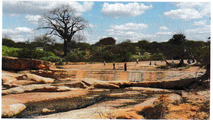
Foto 2: Blick auf die Mauer eines Sanddamms
